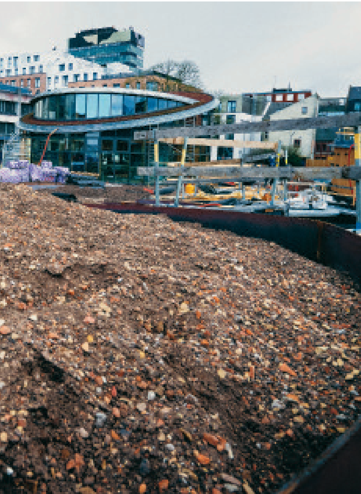
Det nye H.C. Andersens Hus under opbygning. Åbnede for offentligheden Sommeren 2021.
