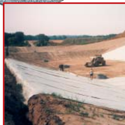
Installation af bentonitmembran på skrænter med anlæg 3 på Klintholm Losseplads.
