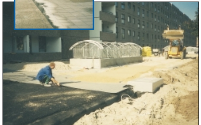
Enkadrain anvendt i forbindelse med haveanlæg på parkeringsdæk.
