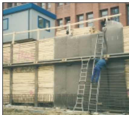
Enkadrain CL anvendt som dræn og vandtætning i forbindelse med etablering af kælder.
