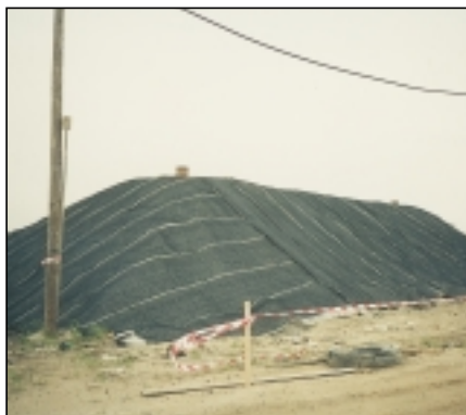
Enkadrain anvendt som gasdræn i deponi.
