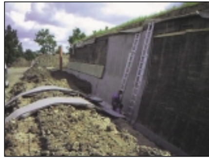
Brug af Enkadrain i forbindelse med vandtank.
