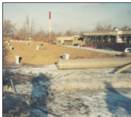
Enkadrain anvendt på taghaver i Hørsholm – rullebredde 5,0 m
