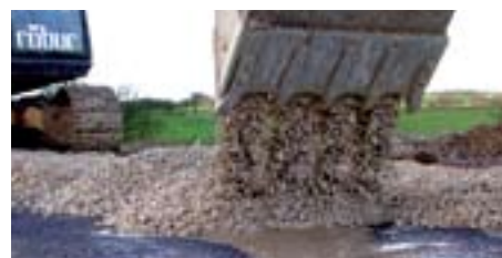
Grusmateriale fyldes på TriAx geonet før trykspredning.
