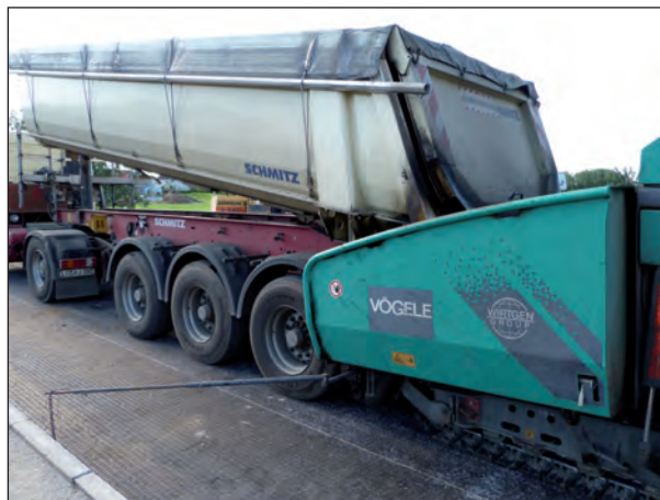
Udlægning af asfalt
