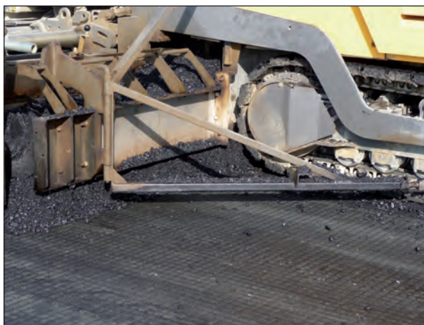
Detalje: Udlægning af asfalt
