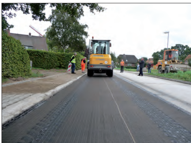
Udlægning med en maskine
