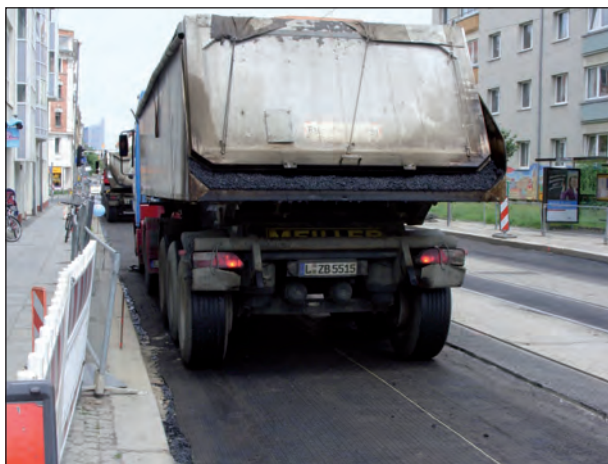
Udlægning af asfalt
