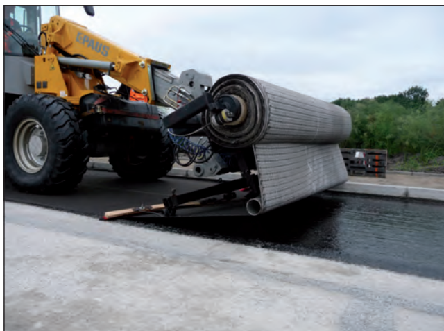
Lægning med en maskine
