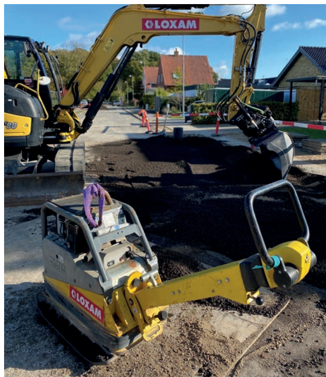
FilterVext Top – vækstmediet kan bankes op maskinelt uden at tage skade.
