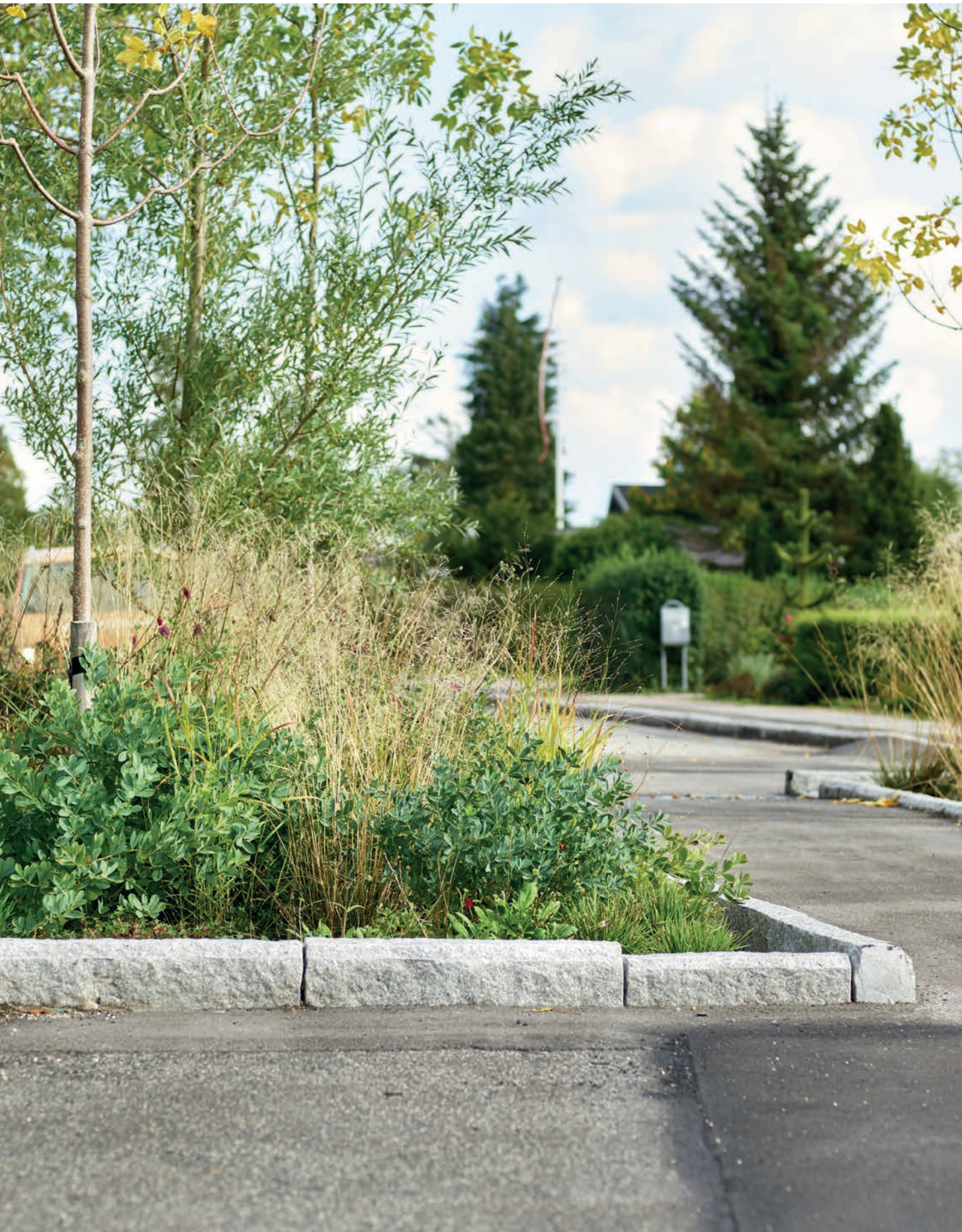
Sænket bedkant for styret overløb.
