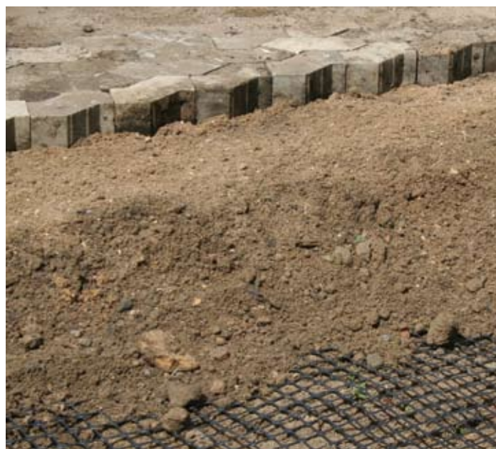
GS-GRID udlagt med ca. 20 cm stabilgrus og belægningssten
