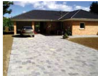
En langtidsholdbar indkørsel med armeringsnet.
