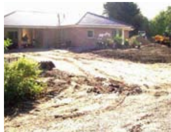
Stabilgrus udkørt på armeringsnet
