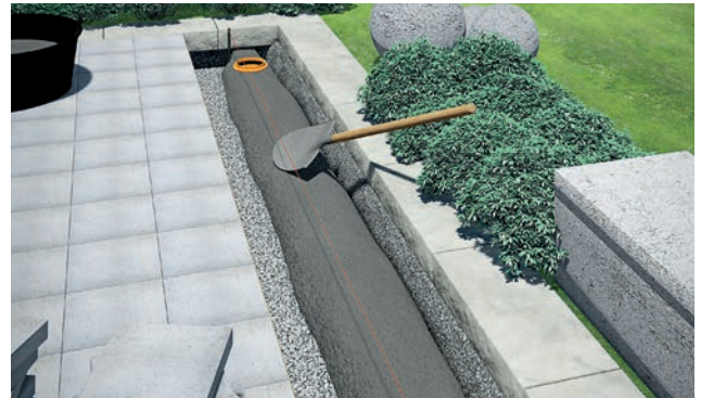
Fyld udgravningsrenden med beton og komprimerer til et fundament
