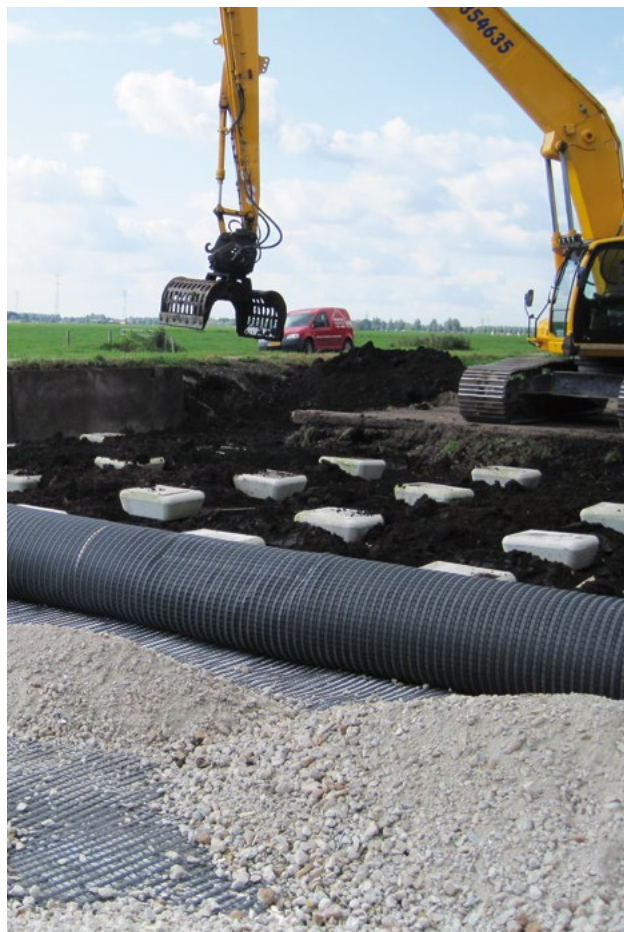
Pålförstärkning armerat med Fortrac Geonät (N:210; Nederländerna)
