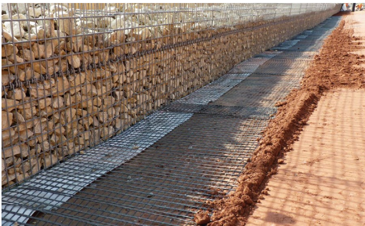
Bottenstabilisering av en gabionvägg (A3 motorväg nära Haseltal, Tyskland)
