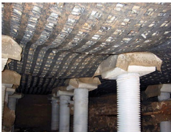
Membraneffekt vid pålförstärkning (Järnväg Bidar-Rawang, Malaysia)
