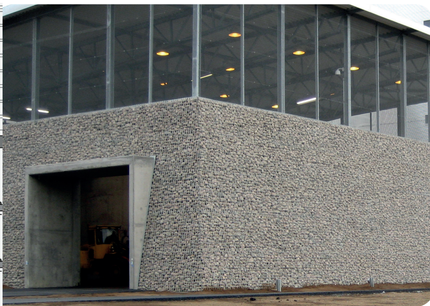
Vector Wall® gabionvägg med fullt integrerat räcke. Jönköping Torsvik, Sverige.
