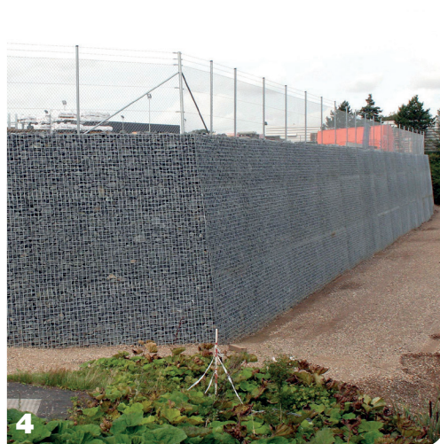
1 Avskärmning och fronnät förbereds för vidare installation 2 Avståndsstöd och förankringsnät fastgjort i fronnätet. Geotextil placerat mellan fronnätet och geonätet 3 Hantering av stenfyllnad mellan fronnät och geotextil 4 Färdig Vector Wall® gabionmur.
