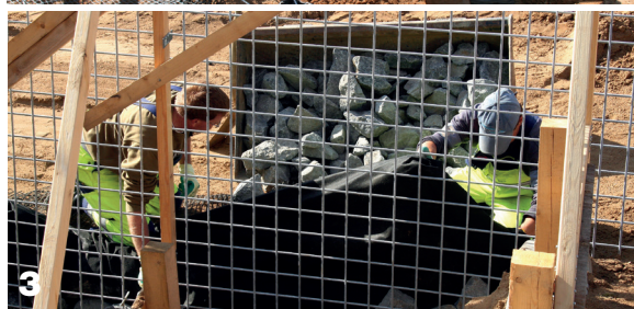
1 Avskärmning och fronnät förbereds för vidare installation 2 Avståndsstöd och förankringsnät fastgjort i fronnätet. Geotextil placerat mellan fronnätet och geonätet 3 Hantering av stenfyllnad mellan fronnät och geotextil 4 Färdig Vector Wall® gabionmur.
