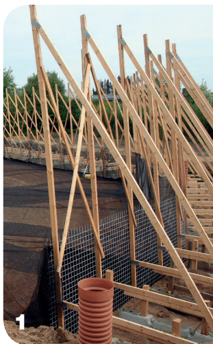
1 Avskärmning och fronnät förbereds för vidare installation 2 Avståndsstöd och förankringsnät fastgjort i fronnätet. Geotextil placerat mellan fronnätet och geonätet 3 Hantering av stenfyllnad mellan fronnät och geotextil 4 Färdig Vector Wall® gabionmur.
