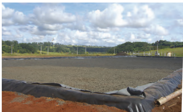
Område forberedt til slamafvanding og opsamling af vand.
