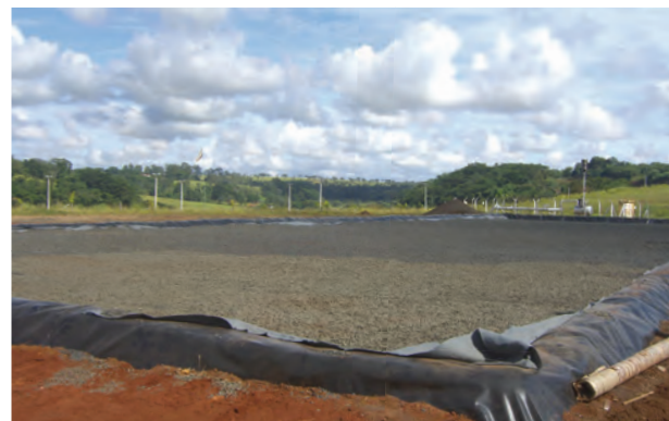
Område forberedt til slamafvanding og opsamling af vand
