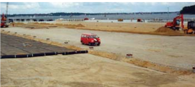
Tensar geonet er særdeles velegnet til kaj anlæg (Letland)
