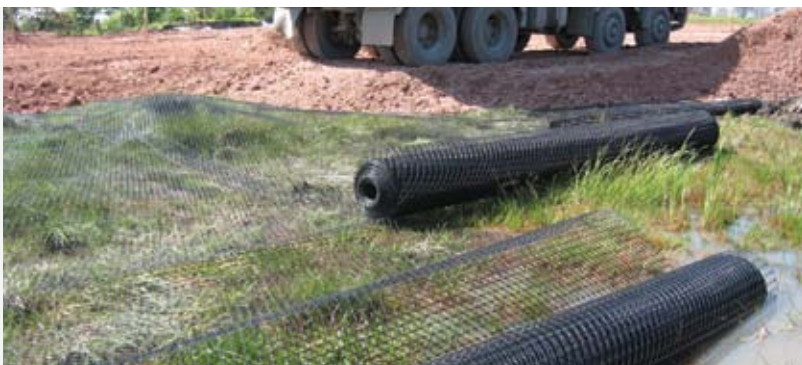
Grundstabilisering af pakeringsareal for tunge transportere ved Lanarkshire
