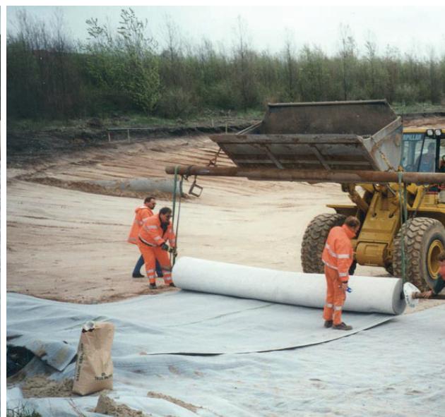
Udlægning af membran
