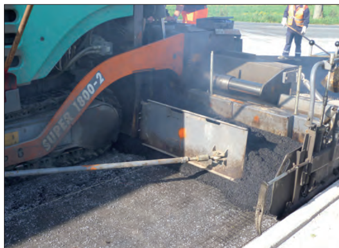
Udlægning af asfalt på SamiGrid®
